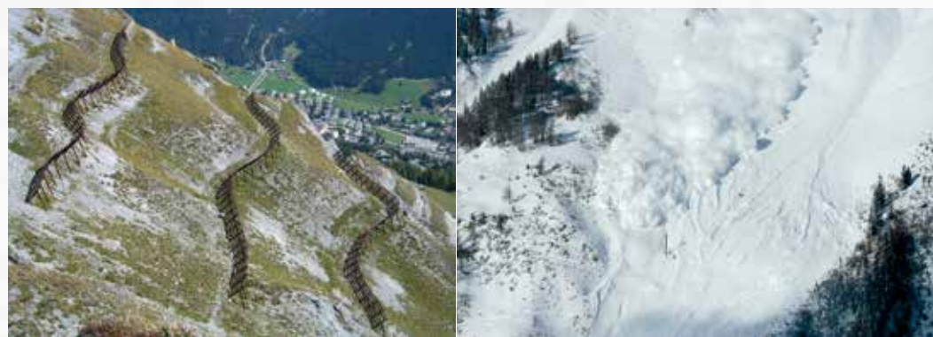
I ripari valangari impediscono la formazione di valanghe e proteggono, per esempio, i villaggi.
