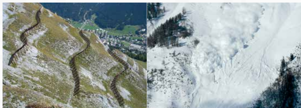
Lawinerverbauungen verhindern die Entstehung von Lawinen und schützen so zum Beispiel Ortschaften.
