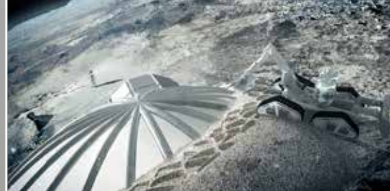
Visualizzazione di una base lunare a cupola multipla in costruzione: dopo il montaggio, i robot coprono le cupole gonfiate con uno strato di stampa in 3D di regolite lunare per proteggere gli abitanti dalle radiazioni spaziali e dai micrometeoriti. Fonte delle immagini: ESA/Foster + Partners
