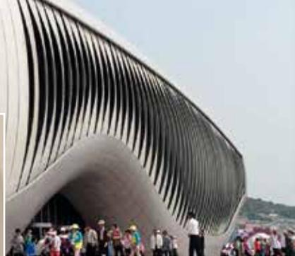
Sistema bionico di ombreggiatura della facciata (principio Flectofin) dell'One-Ocean-Pavillon a Yeosu, Corea del Sud.
