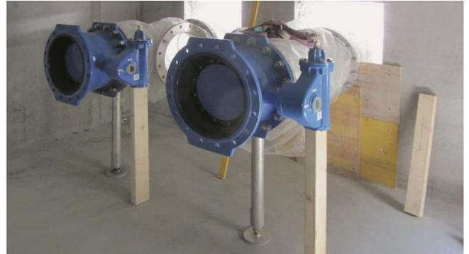
**Abbildung 3:** Montage der Schieber im Rohr Keller Nord
