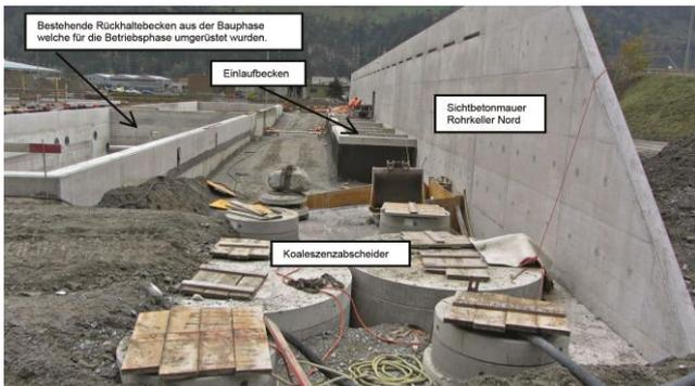
**Abbildung 2:** Rohr Keller Nord kurz vor Abschluss der Bauarbeiten
