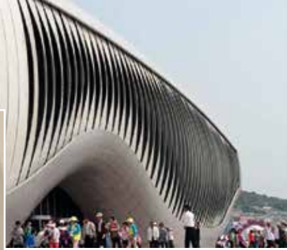
Bionische Fassadenverschattung nach dem Flectofin-Prinzip beim One-Ocean-Pavillon in Yeosu Südkorea
